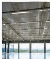
Laje aparente (sem forro)
