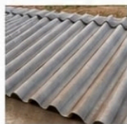
Telha de fibrocimento
